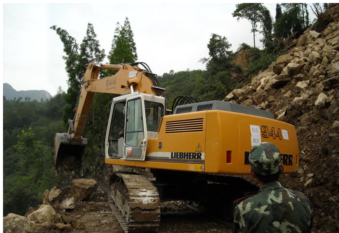
抢修震区道路的利勃海尔 944 挖掘机（盛世捐赠）
